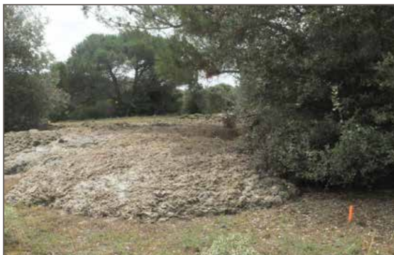
Ce qu'il ne faut pas faire : Dépôt en tas directement sur terrain sableux
